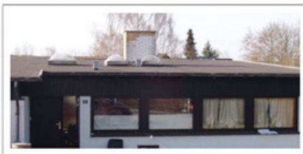
Huset set fra nord:
